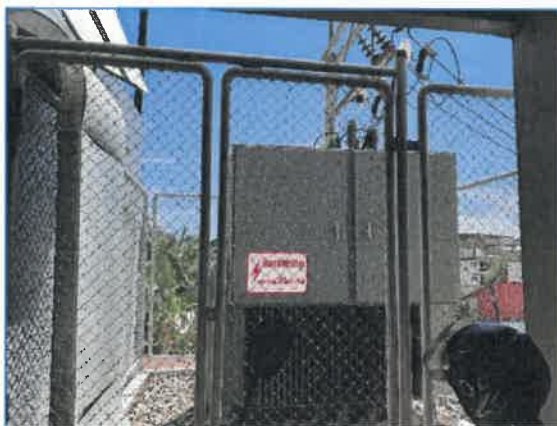
ภาพถ่ายที่ 2.1-8 หม้อแปลงไฟฟ้าของโรงแรม
